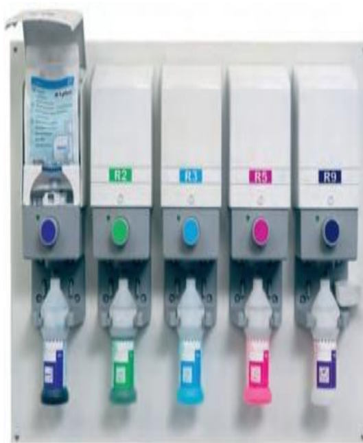
Рисунок 18 Система дозирования и система пополнения прачечного отделения
