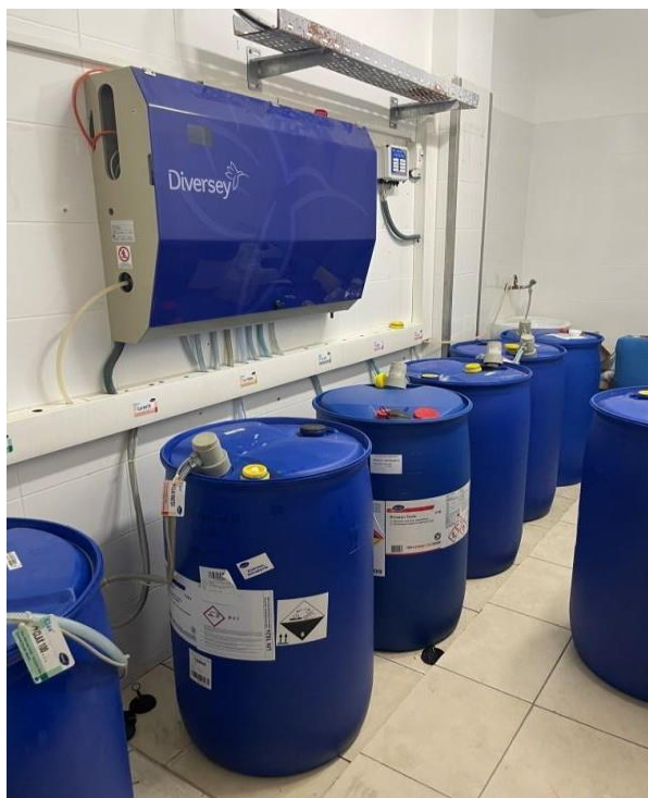
Рисунок 18 Система дозирования и система пополнения прачечного отделения
