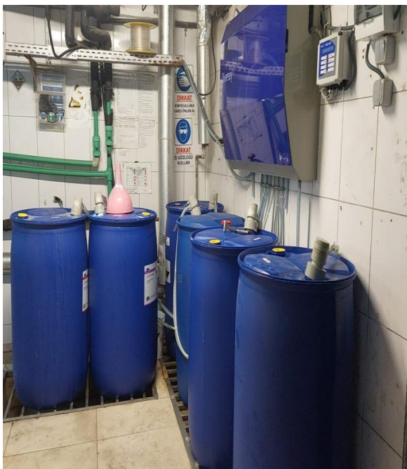
Рисунок 118. Система дозировки и система пополнения прачечного отсека
